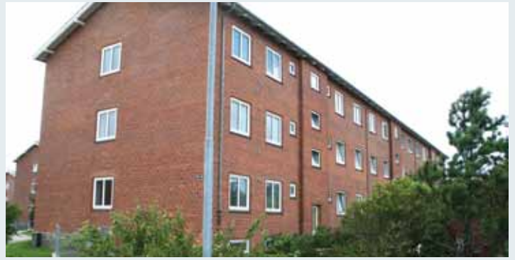
Trindelvej-bebyggelsen i Skagen, der nu står foran en omfattende sanerings- og moderniseringsplan.
